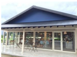
熊本大学の学生さんの 力を借り、空き店舗を 改修しました。
