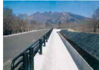
高さ1.5m×幅3mの側溝 (場所によって違いがあります)
