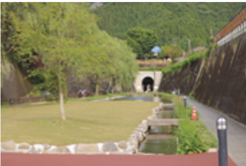
写真2 高森湧水トンネル
